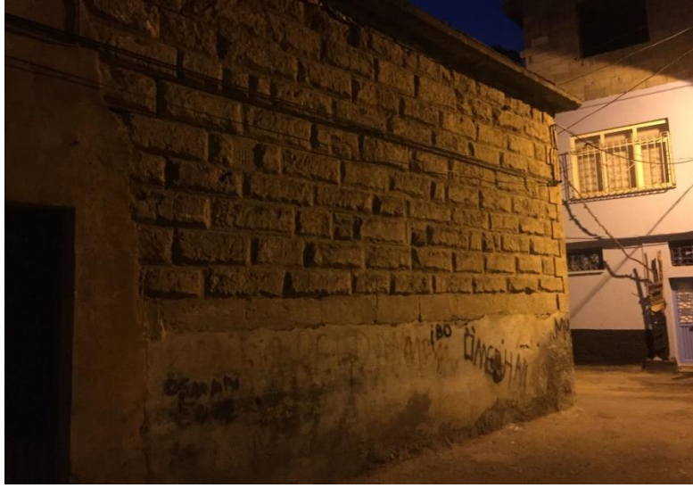
Resim 2. Kireç harcı kullanılarak üretilmiş Kilis evi (Örnek 2)
