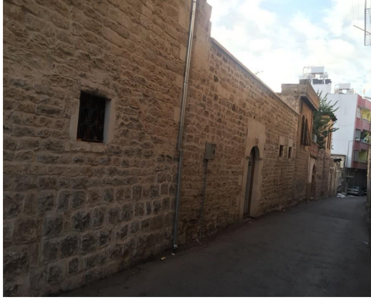
Resim 1. Doğal taş kullanılarak üretilmiş Kilis evi (Örnek1)
