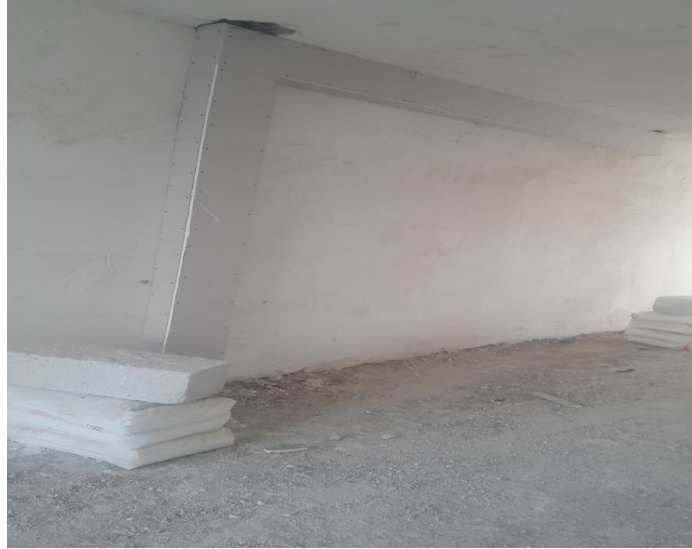
Resim 5 Yapım aşamasındaki bir apartmanda gazbeton kullanımı ( Beşevler Sok. Akpınar Cad. Örnek 3)
