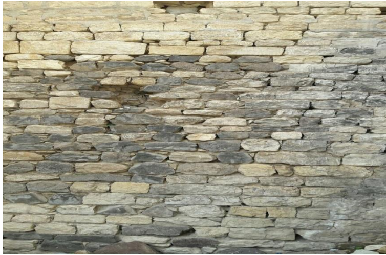
Resim 3. Horasan harcıyla kullanılarak üretilmiş Kilis evi (Örnek 3)
