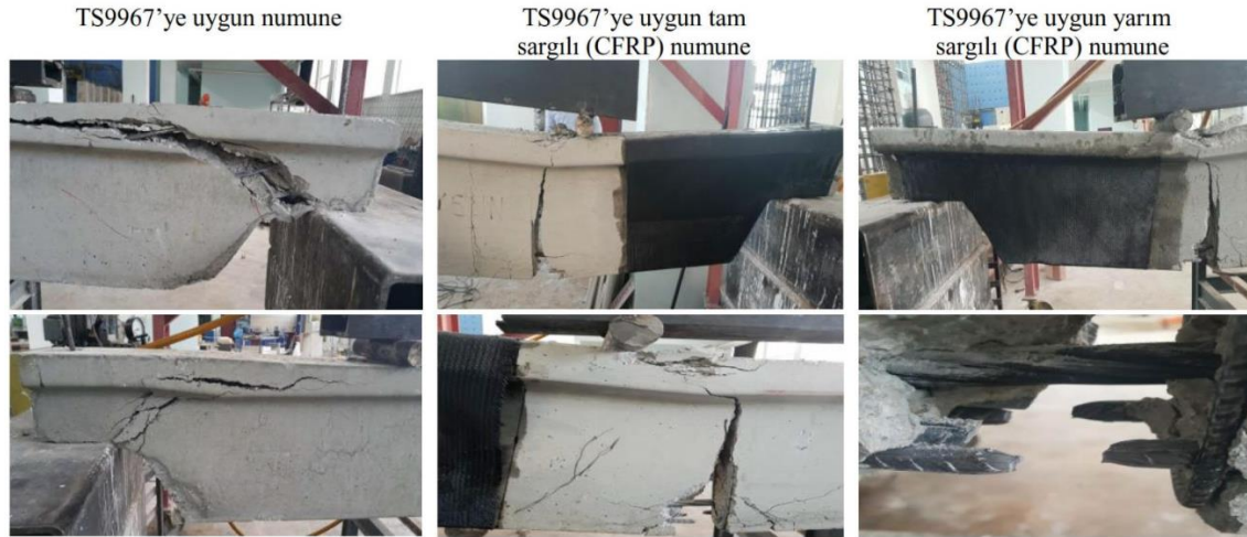
Şekil 6. İnceltilmiş uç bölgelerinde oluşan hasarlar
