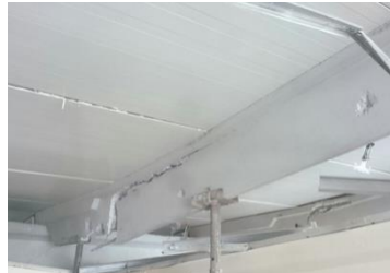
Şekil1. Prefabrike aşık uç hasarı
