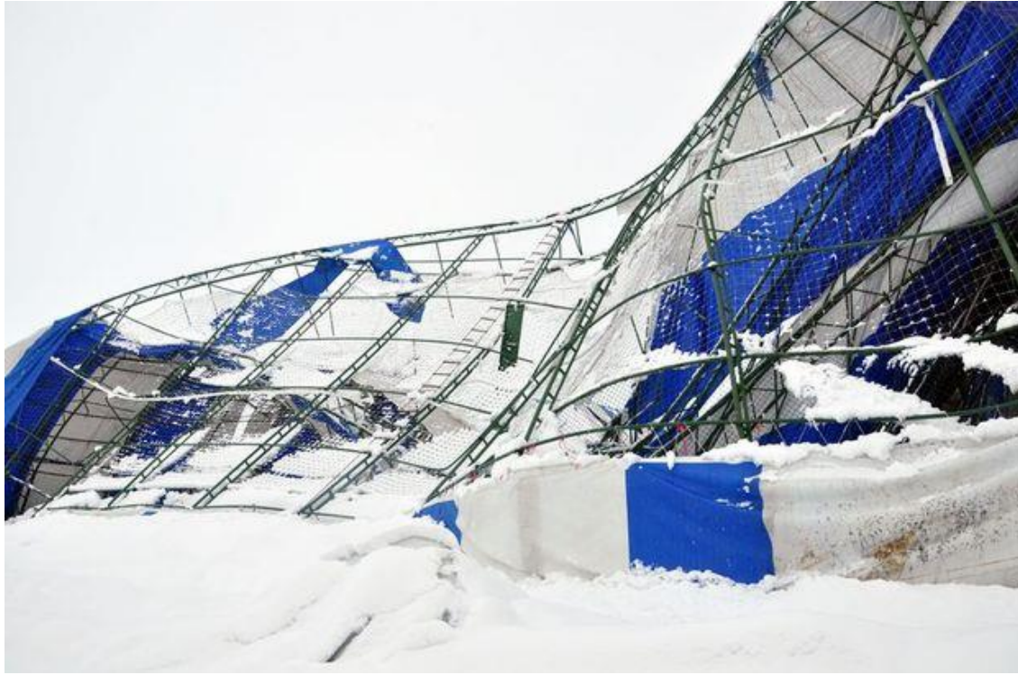
Şekil 1.Ovacık'ta göçen halı sahaya ait sistem [4]
